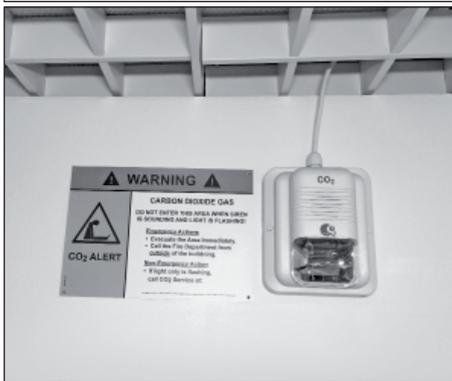
*Buzina/estroboscópio com sinal*
