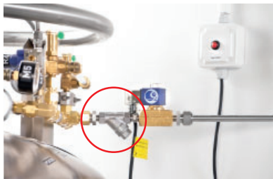
SMB und Absperrventil mit eingebautem Filter
